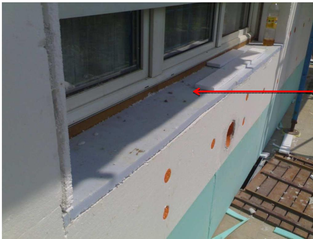
Correzione ponte termico del davanzale mediante la posa di 3+3 cm di XPS
