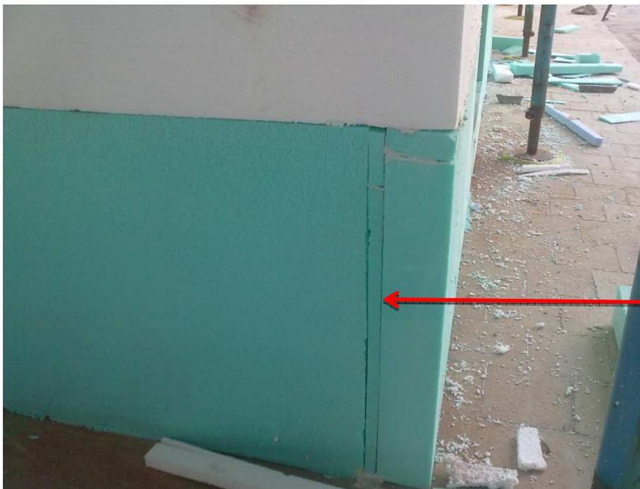
Corretta esecuzione di una fuga tra pannelli discostati per più di 3 mm
