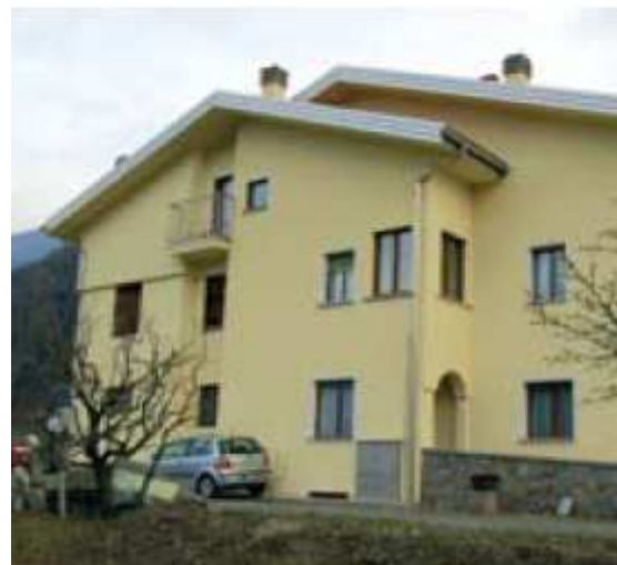
Tresenda di Tegliò (Sondrio), Via Falck - Anno di esecuzione dell'isolamento a cappotto: 2007 - Prodotto applicato: STYROFOAM ETICS - Spessore: 10 cm - Sistema MAPETHERM
