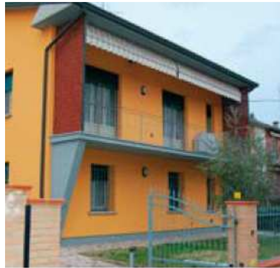
Poviglio (Reggio Emilia), Via Righi Anno di esecuzione dell'isolamento a cappotto: 2007 Prodotto applicato: STYROFOAM ETICS - Spessore: 5 cm
