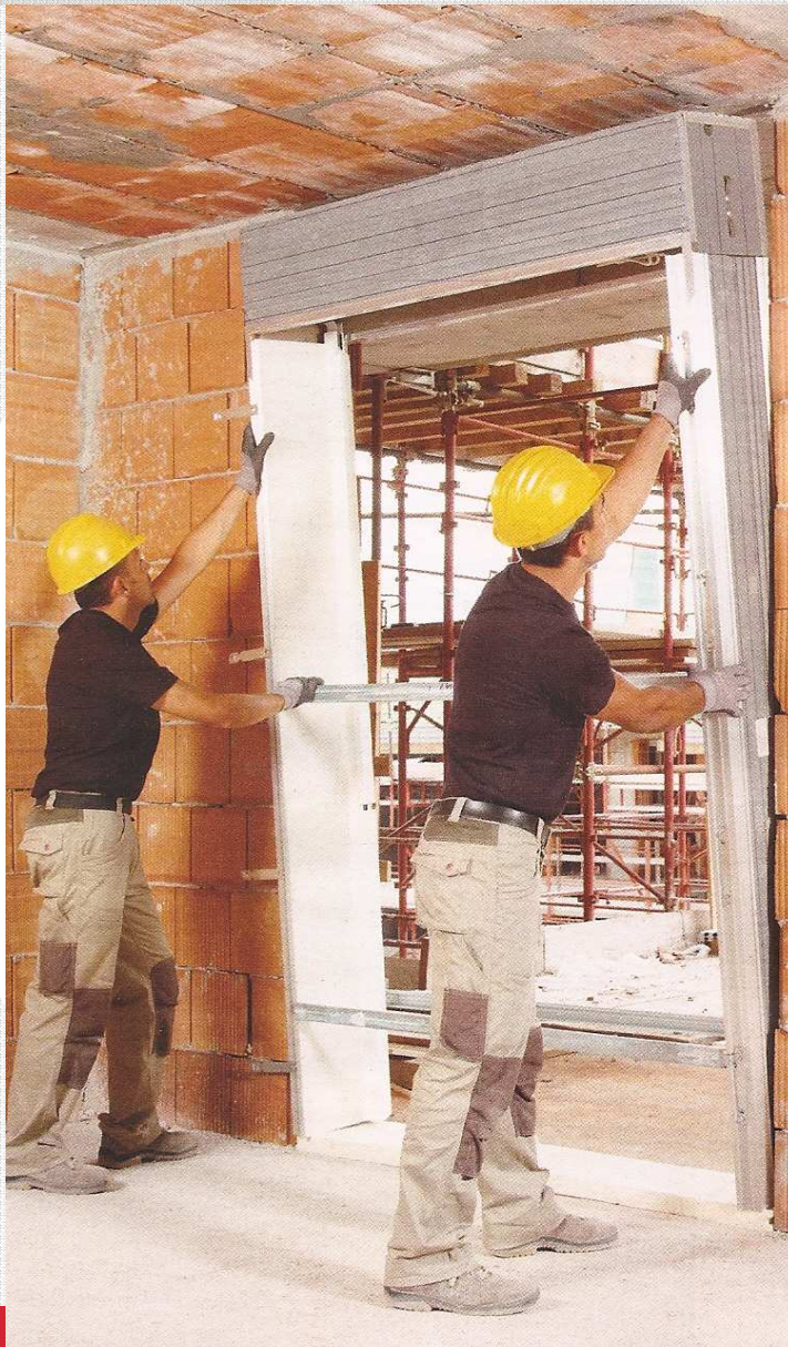
Figura 13 - Foro finestra prefabbricato RoverBlok™ Energy versione Clima, gentile concessione di RoverPlastik S.p.A. realizzato utilizzando polistirene XENERGY della Dow
